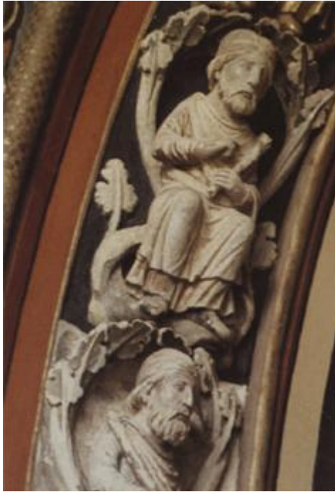
Église Saint-Servais, Maastricht. Petit personnage de la deuxième archivolt du 'Bergpoort' après la restauration de 1992 (Photo E. den Hartog).
